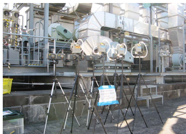
大気調査作業の様子（厚木研究開発センタ）
