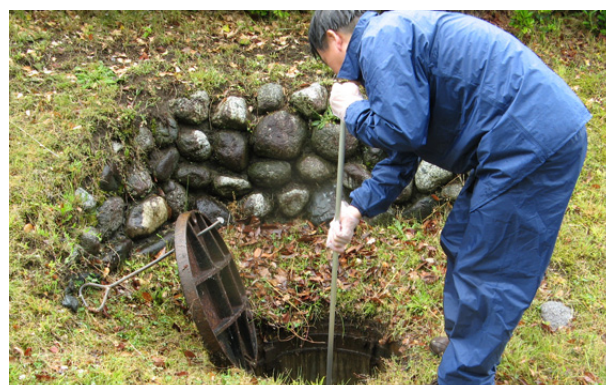
雨水調査作業（厚木）
