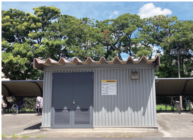
蛍光灯保管庫 (武蔵野研究開発センタ)
