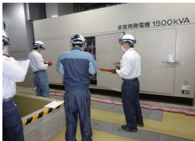
非常用発電機設備重油漏えい時緊急措置訓練の様子 (武蔵野研究開発センタ)
