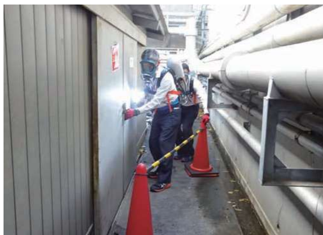
ハロゲン化物消火設備漏えい時緊急措置訓練の様子 (武蔵野研究開発センタ)
