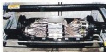
図3 光ケーブル用クロージャ(幹線系)
